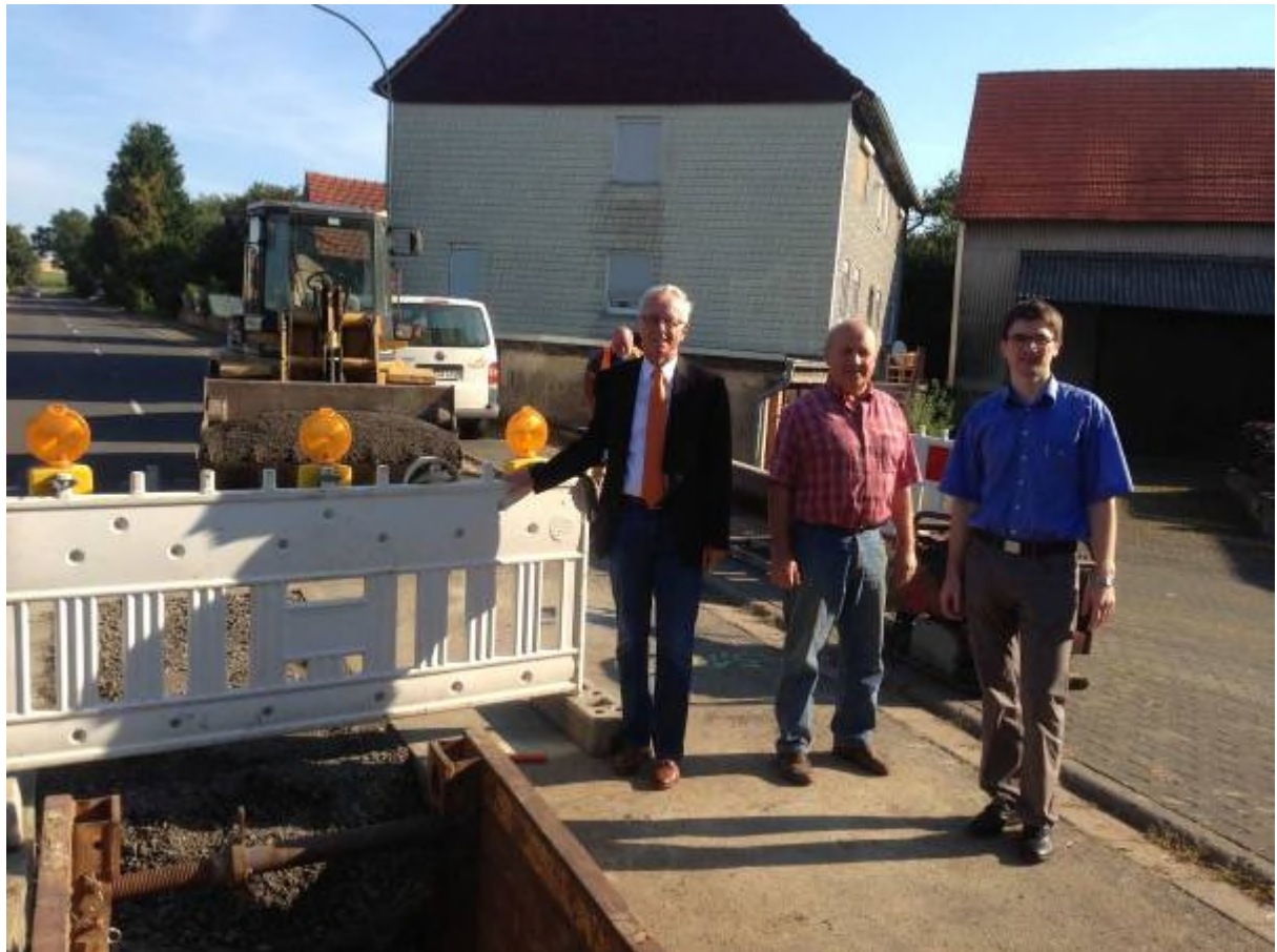
Unser Bild zeigt Bürgermeister Ulrich Künz und Ortsvorsteher Norbert Völzing, die sich über den Fortschritt der Bauarbeiten informieren.
